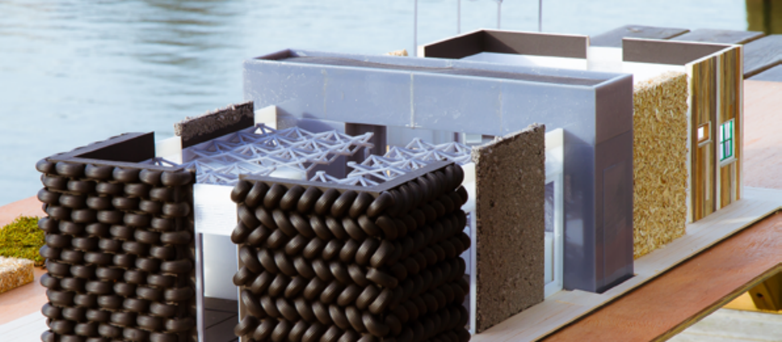
Een maquette van Mobacoa, een biocomposietsysteem dat is onderverdeeld in knopen en vlakken.
