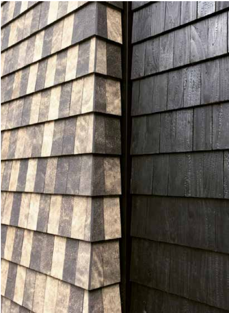
CIRCLE HOUSE (3XN): DEMONSTRATIE-UNIT CIRCULAIRE SOCIALE WONINGBOUW, WAARVAN ZESTIG WONINGEN ZIJN VOORZIEN IN HET DEENSE AARHUS.
